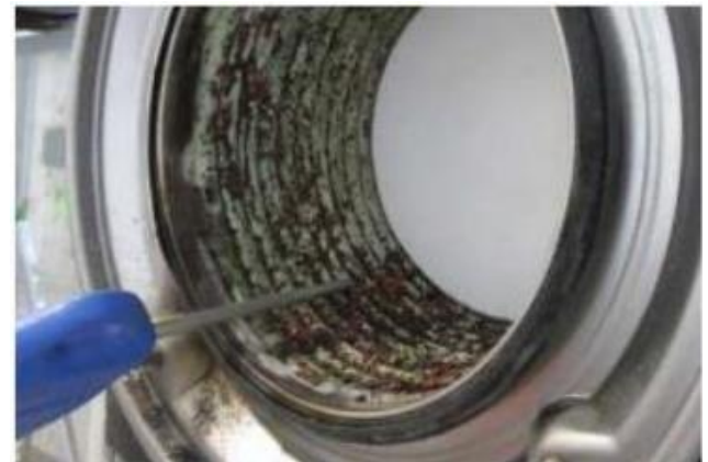
4. Продуть под высоким давлением промежутки между спиралями теплообменника.
