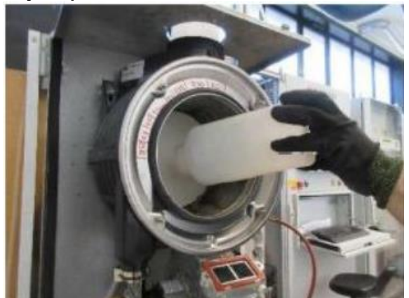
6. Промыть спирали теплообменника водой. 7. Проверить дренаж конденсата. 8. Очистить сифон.
